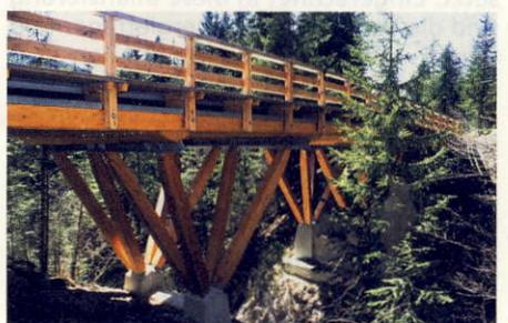
Bild 16: Holzbrücke, auch für den Schwerlastverkehr zugelassen.
