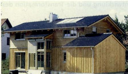
Bild 17: Außenverschalung eines Holzhauses (Niedrigenergiehaus) aus unbehandeltem Lärchenholz.
